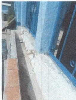
Foto 5: Colocación de ceramico.
