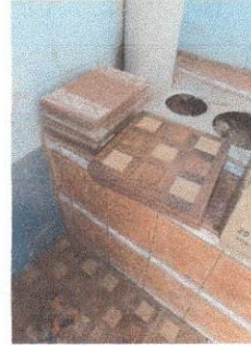
Foto 2: Colocación de cerámico y azulejo para el área de cocina.
