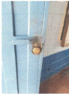
Foto 3: Colocación de chapa en puertas.
